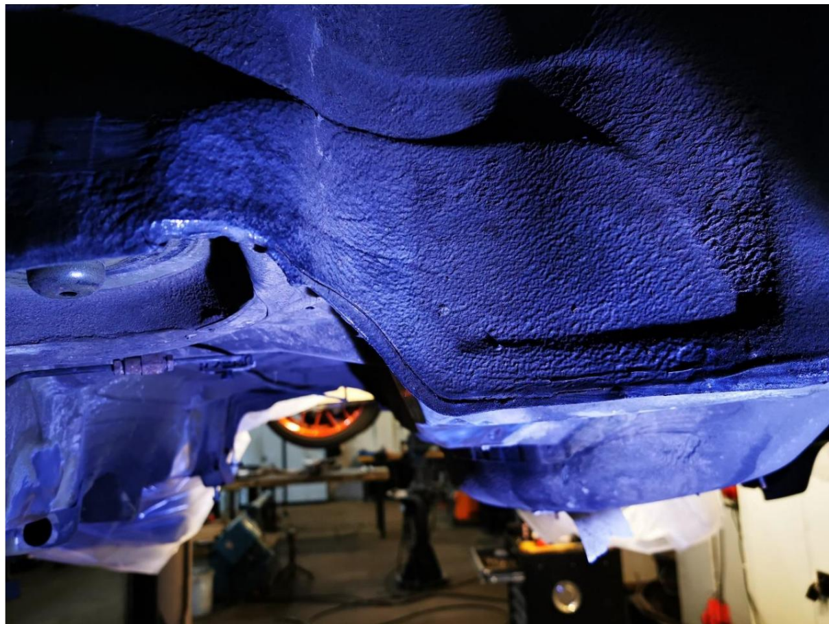
Photo ci-dessus : soudures par points fissurées entre l'assemblage du plancher et le passage de roue, ici Exceptionnellement visible malgré la protection du soubassement
